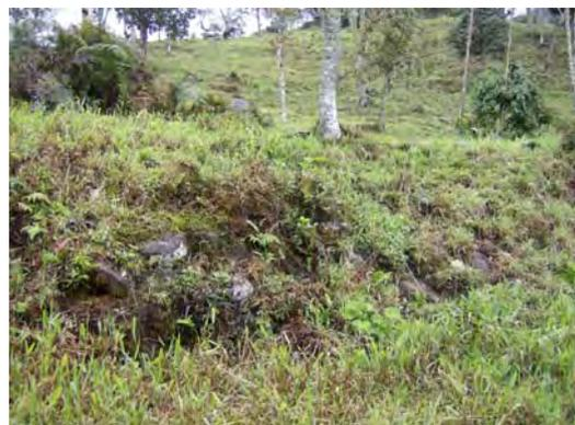
Foto 12: Terraza con contrafuertes de piedra
