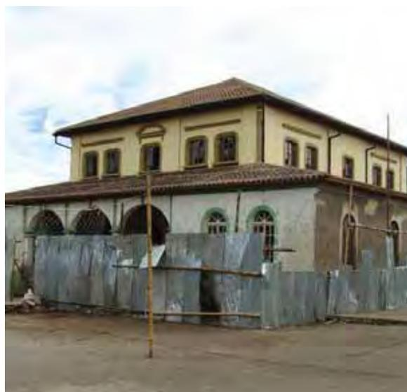
antiguo edificio, con la ejecución de la segunda etapa, donde se intervendrá en pisos de madera, cerámico, escaleras, puertas ventanas de madera, cielos rasos en planta baja, instalaciones eléctricas y sanitarias, accesorios sanitarios, mampostería de ladrillo, entre otras obras.
