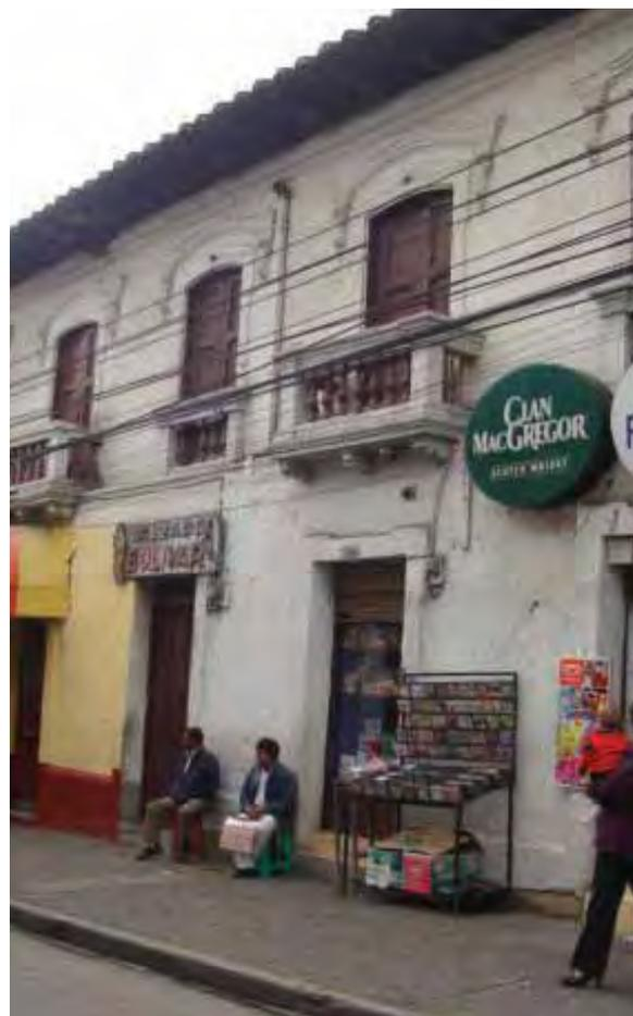
En su sistema constructivo tradicional se desatacan materiales como el tapial, el bahareque, la teja y la madera que se aprecia en las cubiertas a dos aguas, la planta es de tipo rectangular sobre línea de fábrica, cuya estructura muraria de sus fachadas conforman una plaza central que corresponde a su diseño original.
