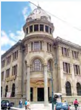
Edificio del Correo, Riobamba.
