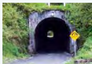
Túnel Agoyán, Baños.
