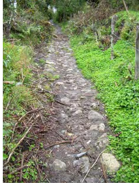
Figura 5. Pavimento intacto (ancho=1.7m)
