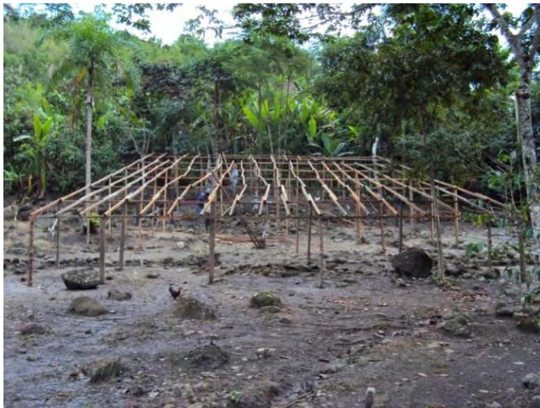
Foto 3: estructura de madera del techado con vigas y postes
