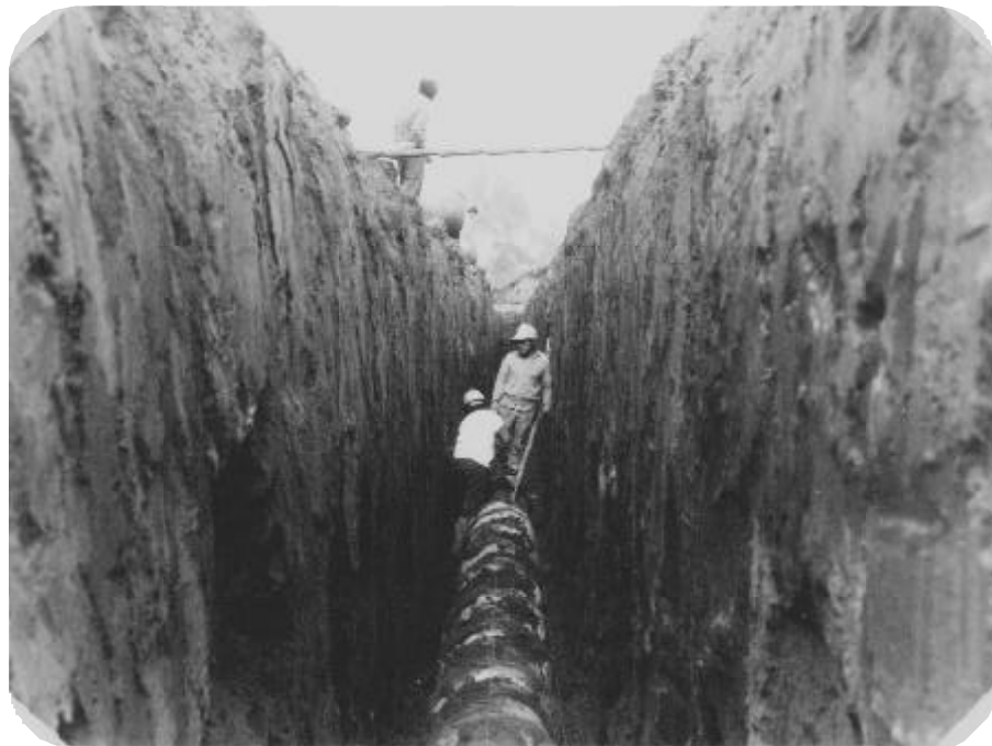
FOTO2.- Zanja principal para desagüe.
