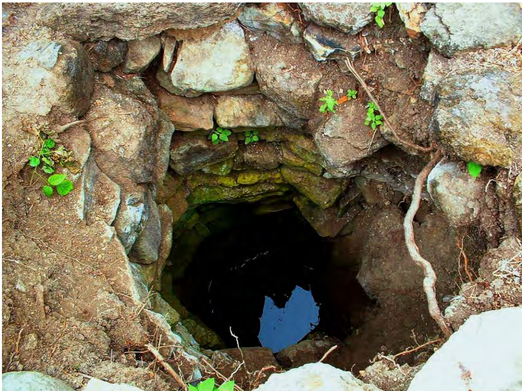
Fig.VI. 20. Puits de stockage de l'eau de Cerro Jaboncillo (Photo A.T.H.).
