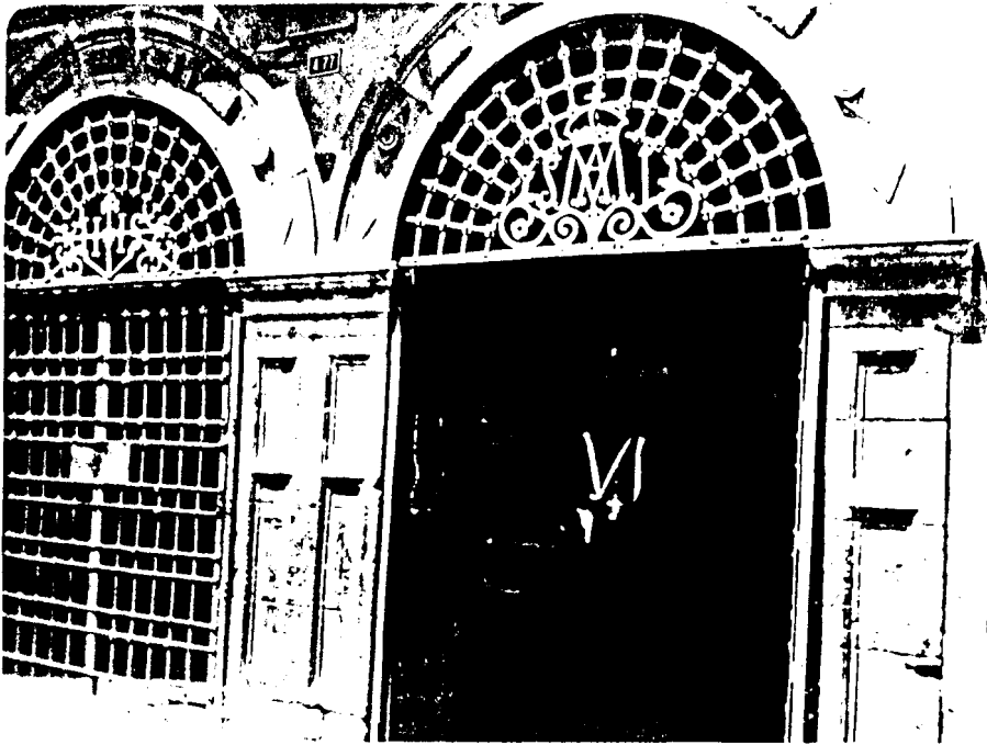
Puertas de acceso al área del zaguán
