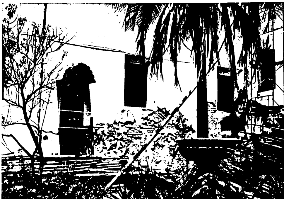
Vista de la esquina sur-este del patio del Claustro del Museo
