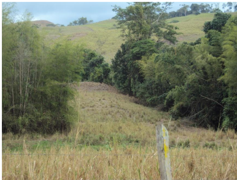
Figure 23 : terrassements du site n° 51
