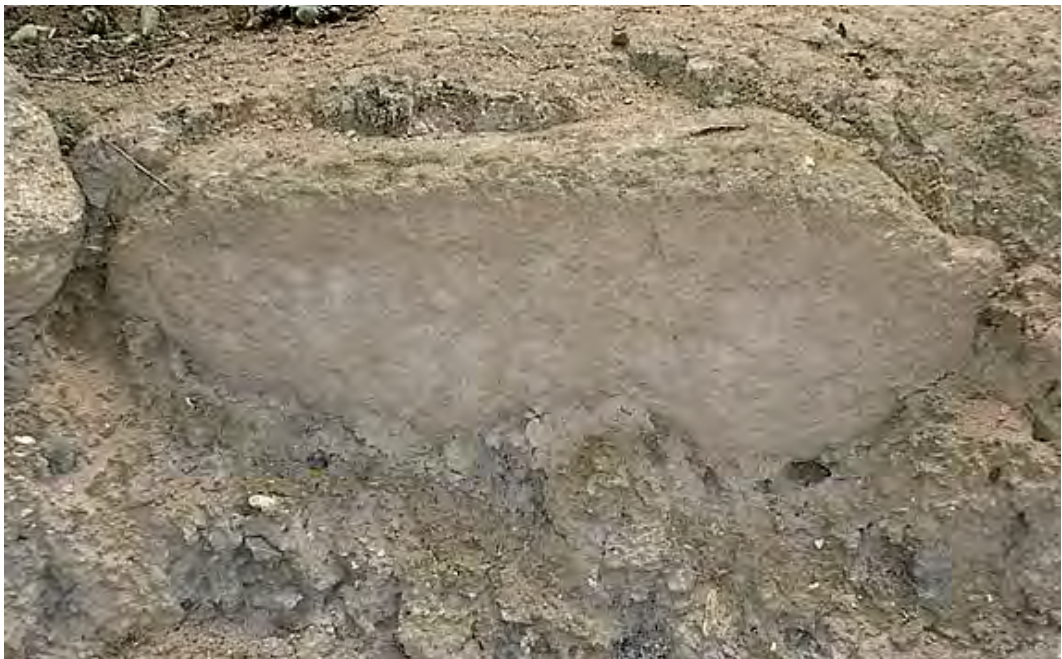
Foto 7: Detalle de una piedra y del mortero que rodea la base de la piedra
