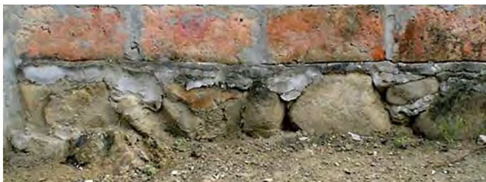
Foto 13: Piedras utilizadas como base/riestra en construcciones modernas
