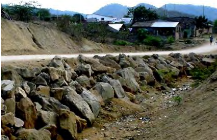
Foto 11: Piedras como refuerzo de drenajes artificiales en Puerto López
