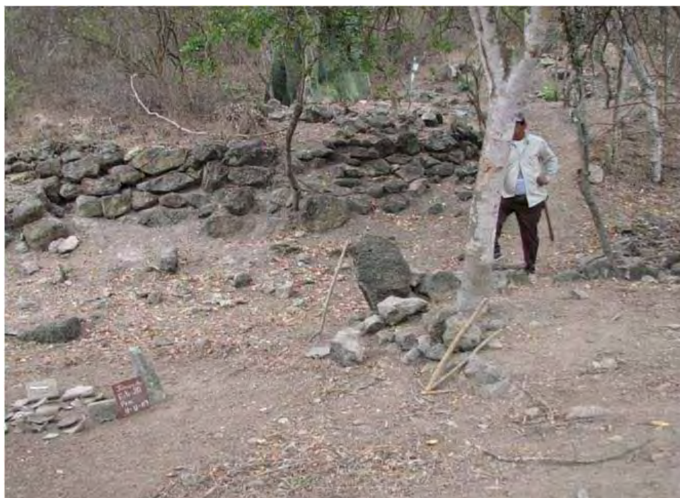
Muro de contención de una terraza en el Cerro Jaboncillo
