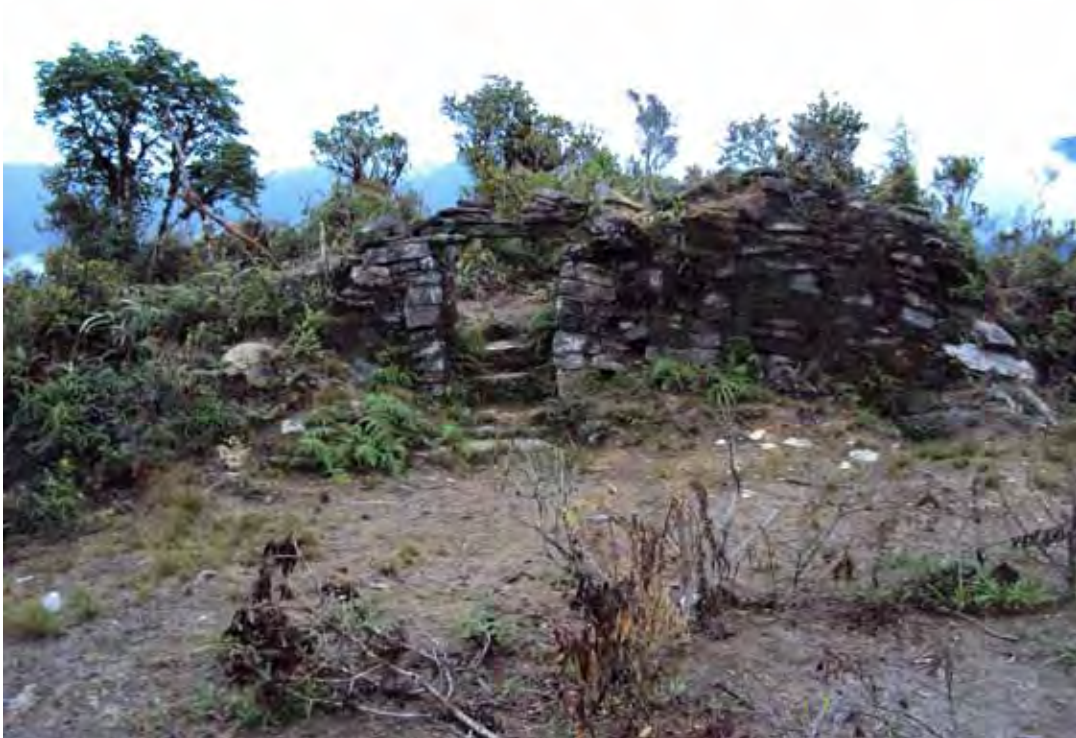
Vista de la estructura norte del pucará de Trincheras
