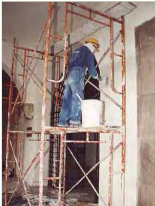
Limpeza de juntas después de la colocación del nuevo revoque.
