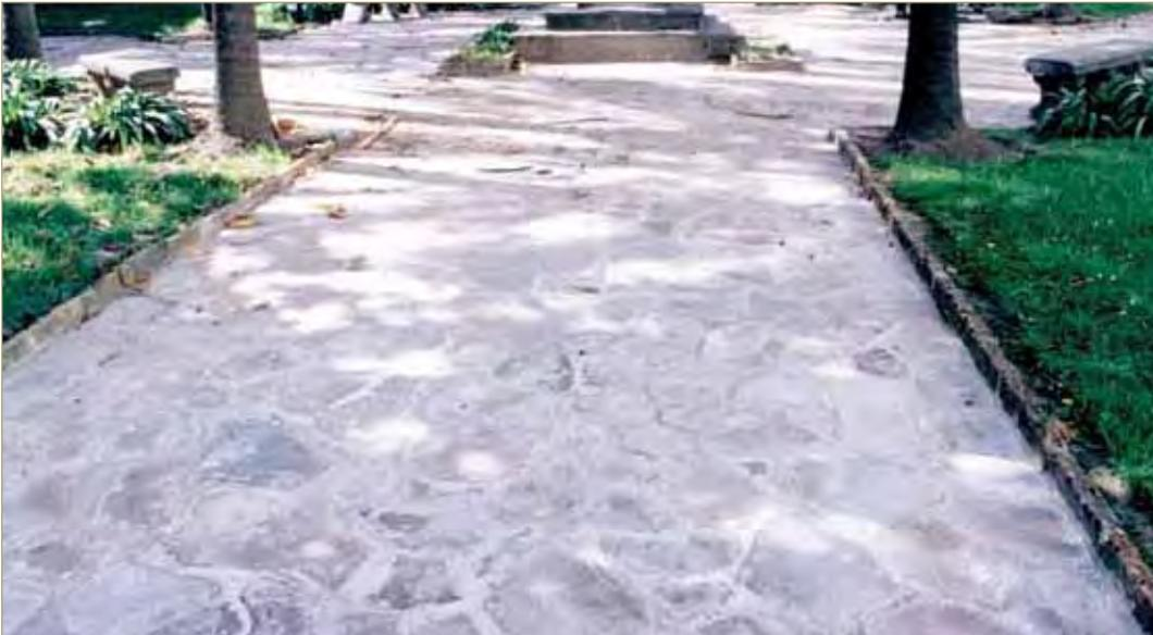
◀ Detalle del piso concluido el trabajo de fundición de contrapiso y reasentado de piedra
