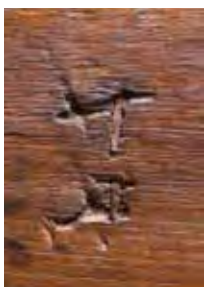
Mediante clavos de hierro forjado
