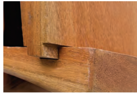
Unión machihembrado
