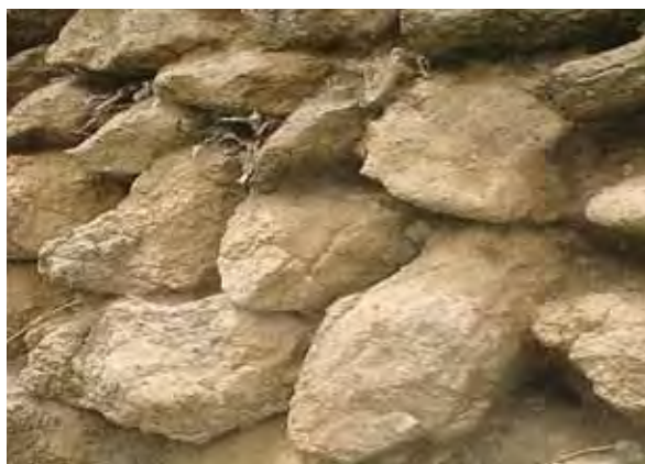
Pared con bloques de cangahua, Chimborazo
