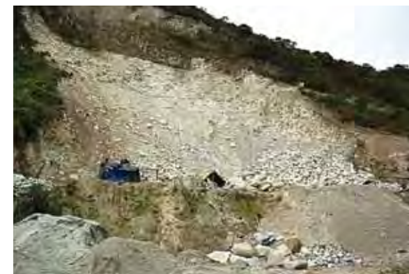
Derrumbe en la cantera de Saraguro
