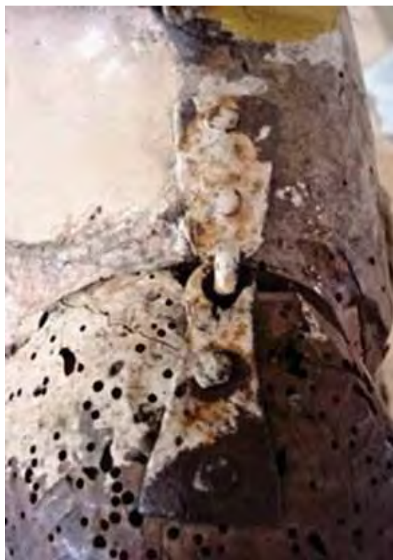
Deterioro producido por la presencia de xilófagos.
