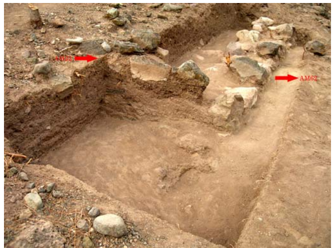
Foto.33 Vista general de la Trinchera5 en las unidades AE7S1-AE10S1
