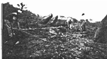
Foto No 11 Trazo de eje y línea perpendicular de registro
