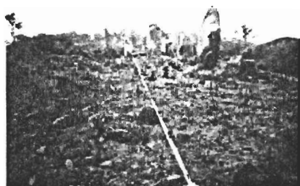
Foto No 10 Trazo de eje para registro
