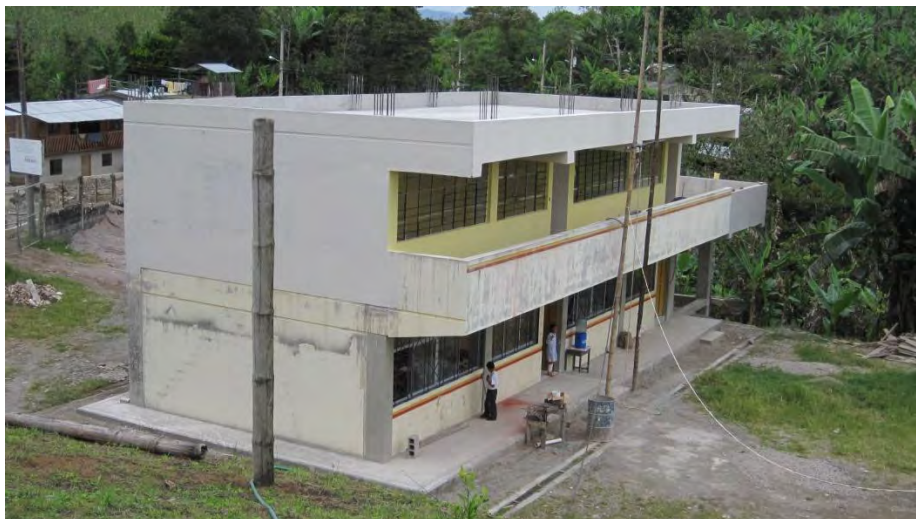
Figura 22. La etapa final de construcción de nuevas aulas (planta alta) para la escuela de Palmitopamba. Este proyecto fue financiado principalmente por el Gobierno Provincial de Pichincha pero ayudamos a los padres de familia con la parte que tenían que aportar ellos.
