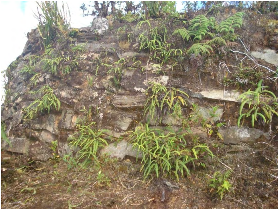
Foto 23: Muro Sur Nivel 2
