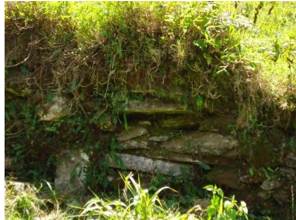
Foto 9: detalle del muro 1
