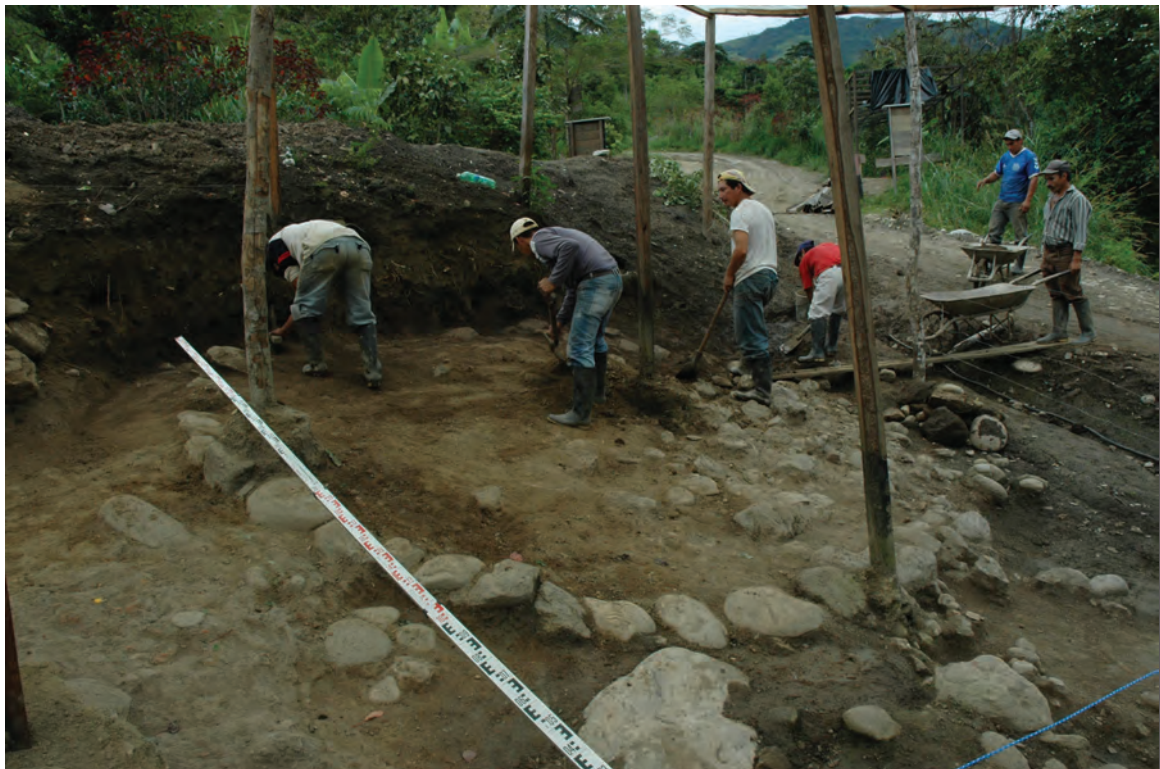
Foto 027 Proceso de excavación de la Estructura # 2
