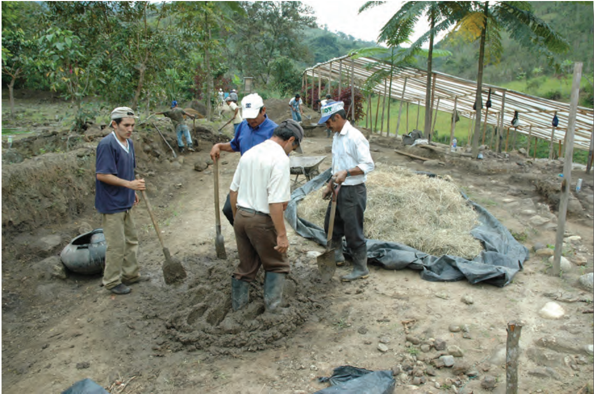
Foto 006 Preparación de argamasa tradicional para consolidación de muros.
