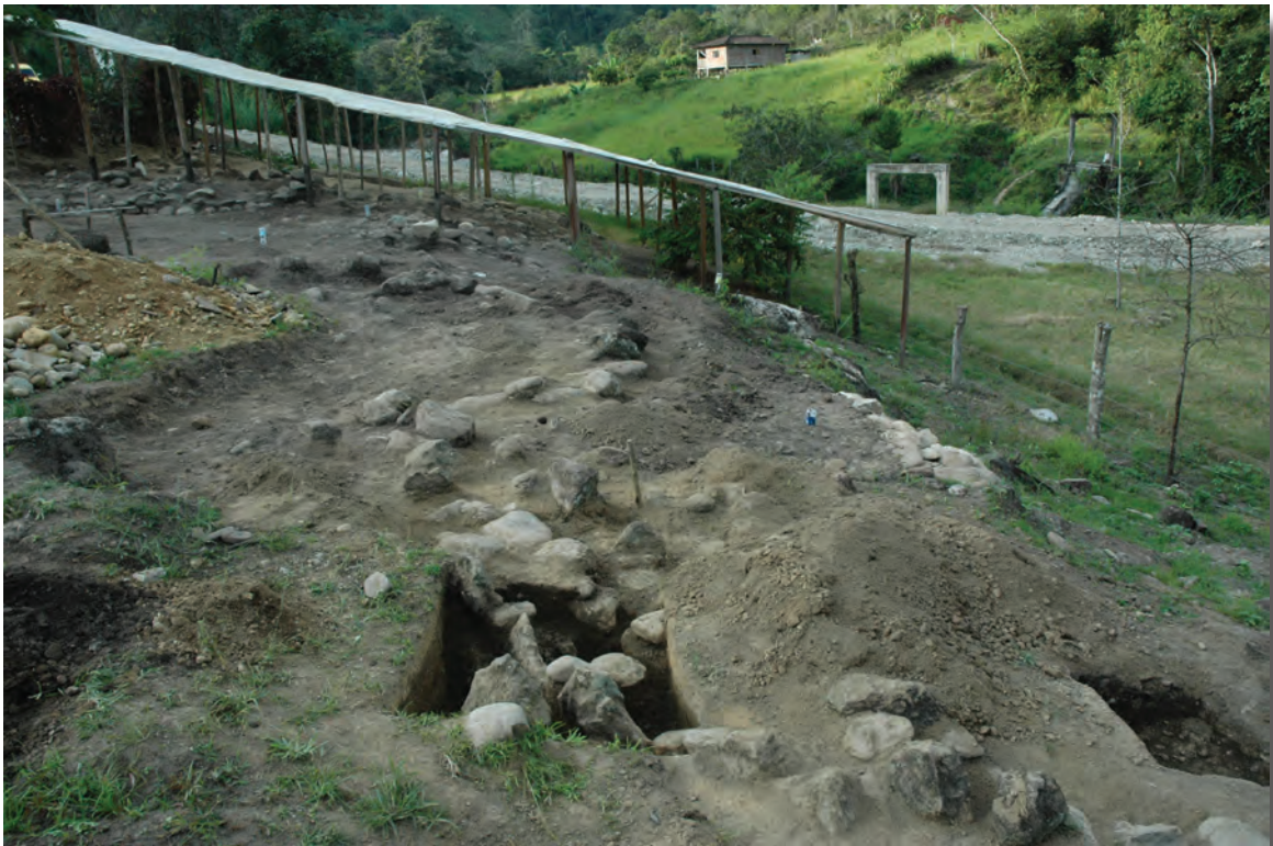
Fotos 017 y 018 Muro de contención filo oriental de la terraza.
