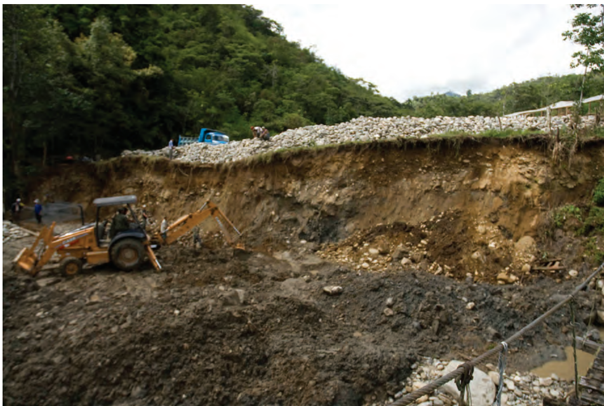
Foto 040. Trabajos de construcción de muro de gaviones sobre la margen del río Valladolid.
