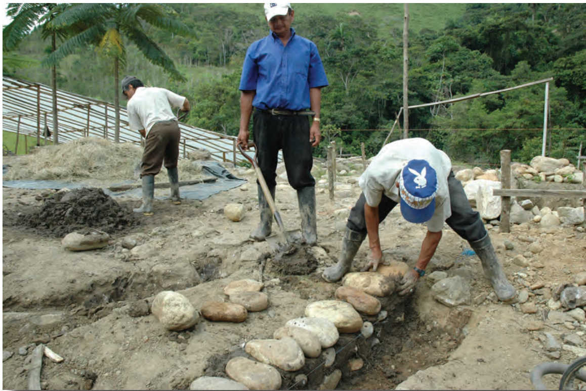
Fotos 009 a 013. Consolidación de cimientos expuestos
