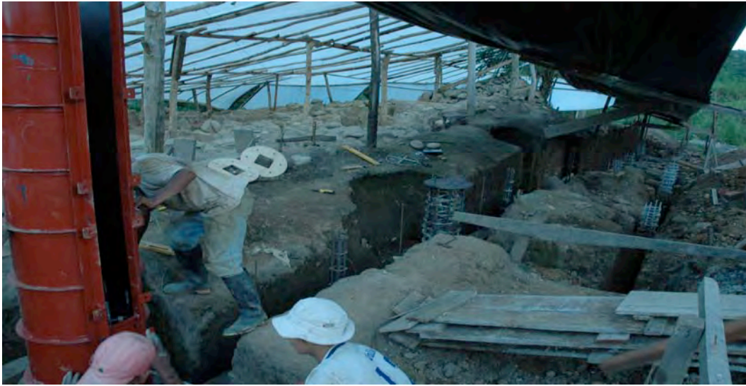
Foto # 63: Construcción de bases y columnas de la estructura en la zona explorada.
