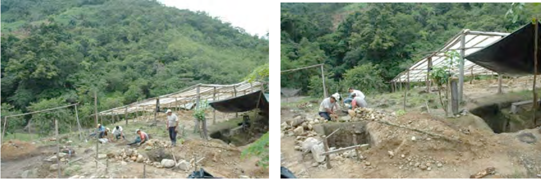
Fotos # 74 y 75: Exploración y excavación de los pozos del extremo norte.
