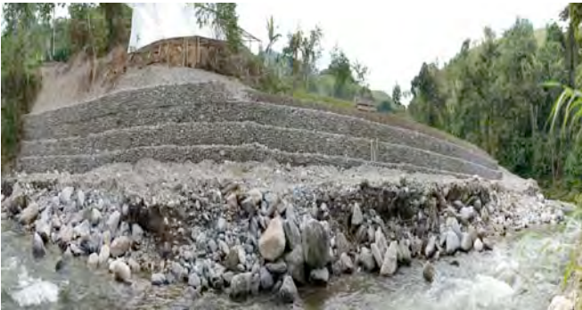
Fotos # 16 y 17: Muros de gaviones en la margen occidental del río Valladolid.
