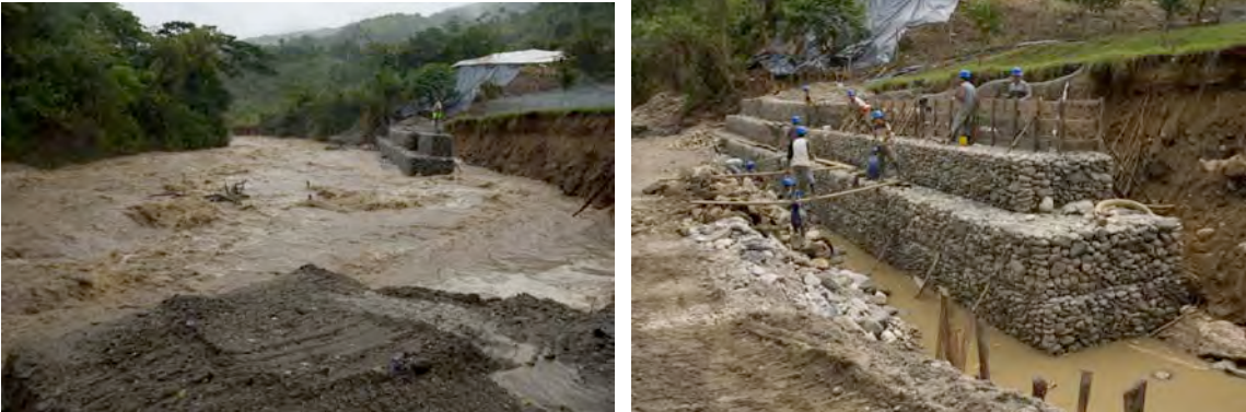
Fotos # 3 y 4: Margen sur oriental del río. Construcción de gaviones para contener el escarpe de la terraza fluvial.
