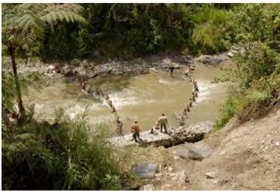
Fotos # 1 y 2: Personal militar del Batallón de Selva 17, ZUMBA participando en la construcción de gaviones para contener el desplome de terrenos al río. Marzo 2008.
