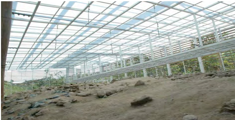
Fotos # 114 y 115: Estructura de protección edificada por la Unidad de Gestión del Decreto de Emergencia, Ministerio Coordinador de Patrimonio Natural y Cultural.
