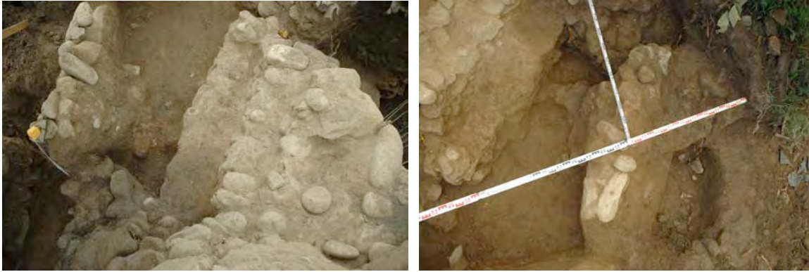
Fotos # 108 y 109: Últimos remanentes de muros y contrafuertes escalonados al extremo sur.
