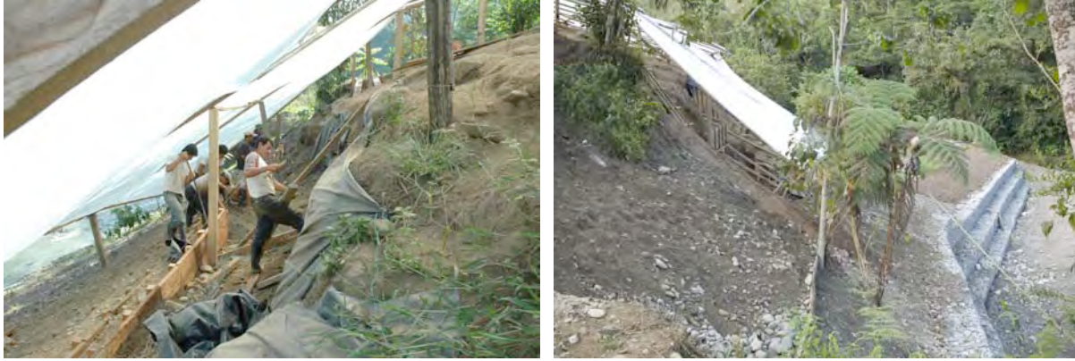
Fotos # 97 y 98: Consolidación del terreno con muros de tablón y relleno de materiales permeables para afianzar y drenar la pendiente.
