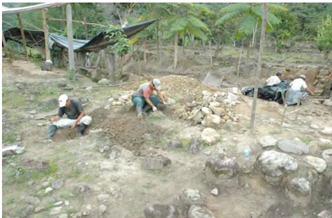
Fotos # 72 y 73: Exploración y excavación de pequeños pozos para soportes de celosía.
