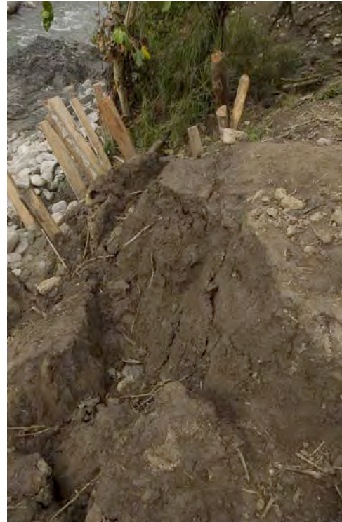
Fotos # 18 y 19: Deslizamiento y apuntalamiento del terreno en la esquina sureste del sitio.
