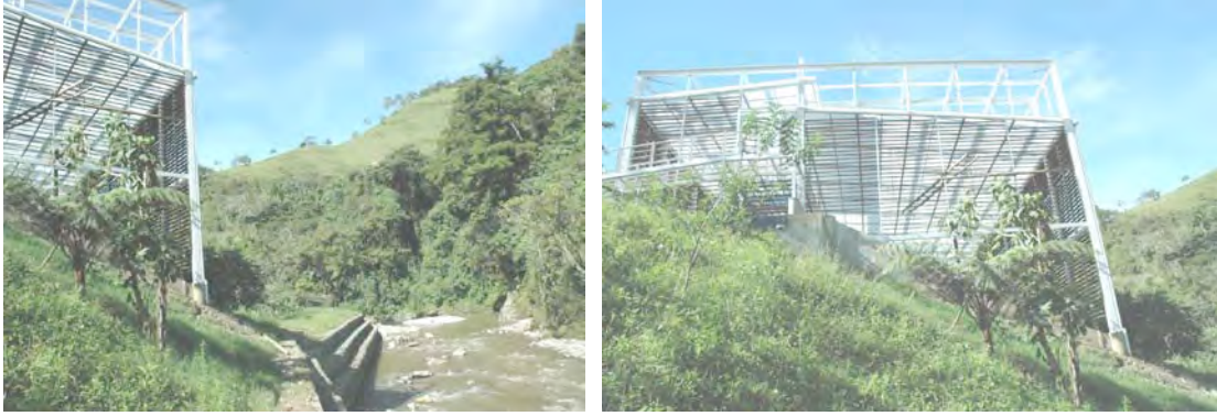
Fotos # 112 y 113: Techumbre de protección sobre la margen consolidada del río Valladolid.
